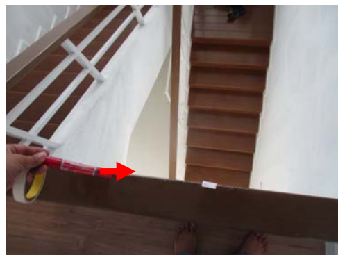
Pic:10 ราวบันไดไม้ขอบสีต่าง ควรขัดเก็บสีใหม่
