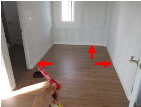
Pic:15 ห้องนอน1 พื้นลามิเนตตามภาพดู ควรแก้ไขอัลลิ้ม เก็บซีลิโคนขอบให้เรียบร้อย
