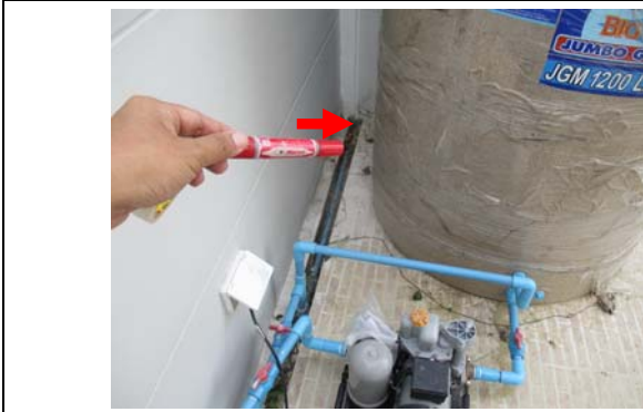
Pic:9 หลังบ้าน ร่องรอบถังน้ำดีขยะ ดินไม่เต็ม ควรเอาขยะออกและเติมดินให้เต็ม
