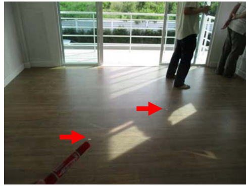
Pic:14 ห้องนอน1 พื้นลามิเนตตามภาพดู ควรแก้ไขอัลลิ้ม เก็บซีลิโคนขอบให้เรียบร้อย
