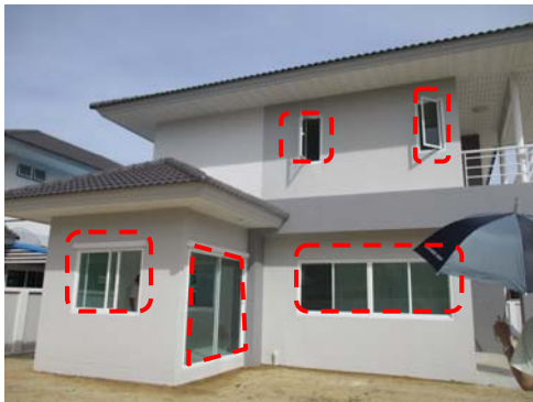
Pic:3 ข้างบ้าน ขอบปูนรอบหน้าต่าง ประตูไม้เรียบ บันรอบ ขอบปูนรอบหน้าต่างบันทุกบาน ควรโป้ว ขัดเก็บสีใหม่
