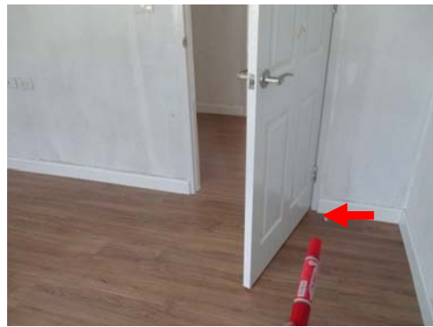
Pic:32 ห้องนอน3 พื้นลามิเนตตามภาพดู ควรแก้ไขอัดลิ้ม เก็บซิลิโคนขอบให้เรียบร้อย
