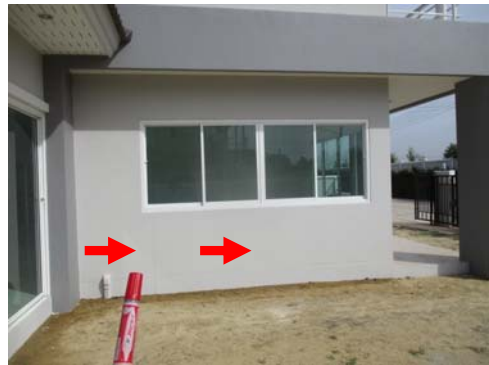
Pic:4 ข้างบ้าน ผนังบ้านมีรอยร้าว ได้หน้าต่างตามภาพ ควรโป้วขัดเก็บสีใหม่
